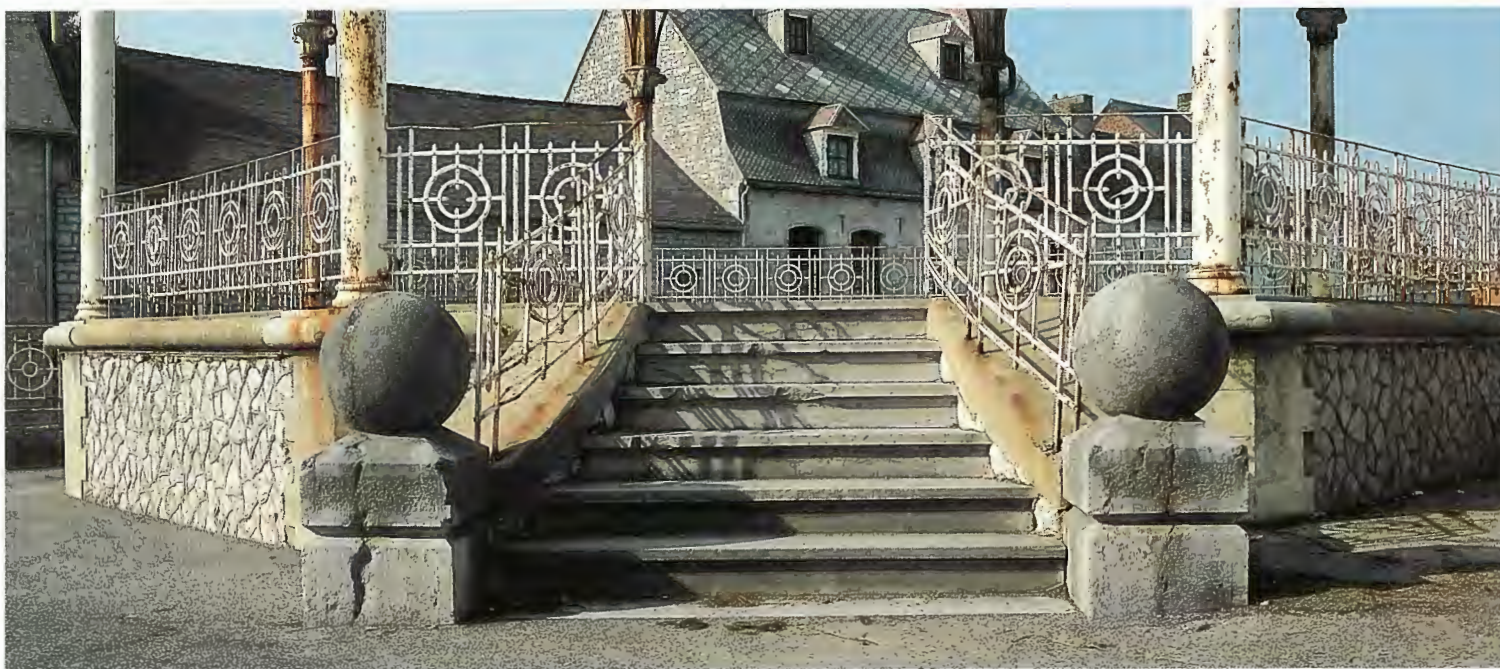
55. Cerfontaine, escalier évasé avec piles en pierre calcaire.
