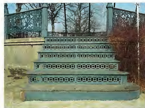
58. Huy, escalier en fonte ajourée.
