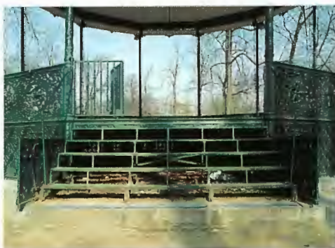
56. Bruxelles, parc Royal, escalier escamotable en fonte.
