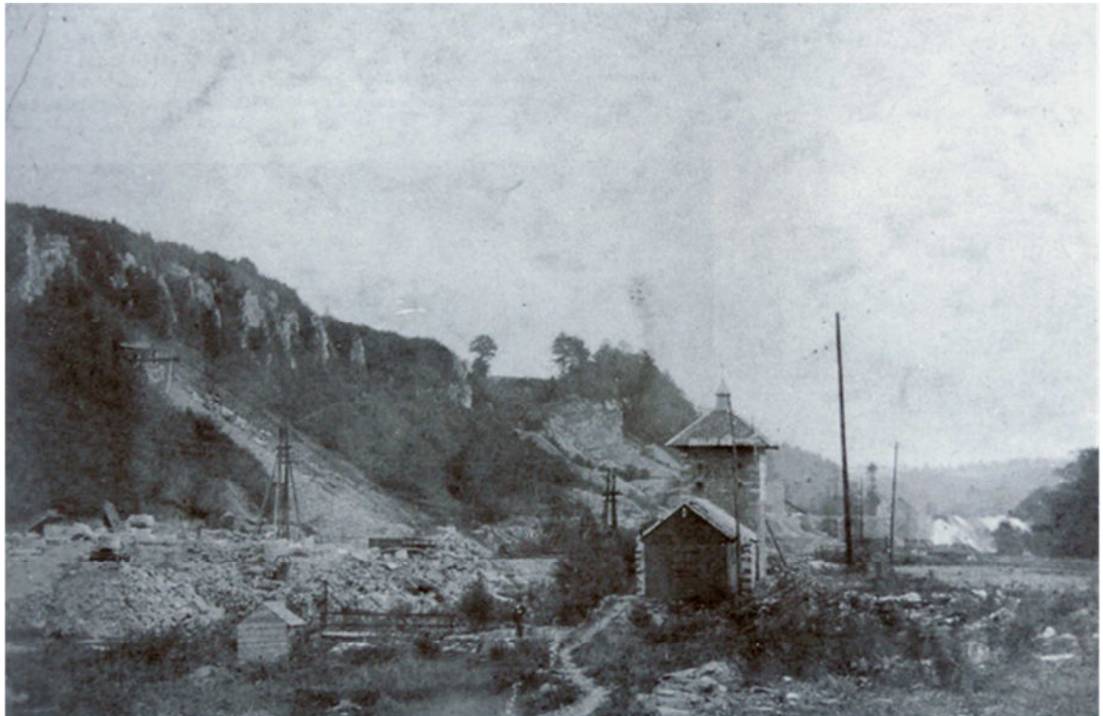
La centrale hydroélectrique au cœur de la Carrière du Bocq, vers 1900, à Chansin (Coll. Privée).
